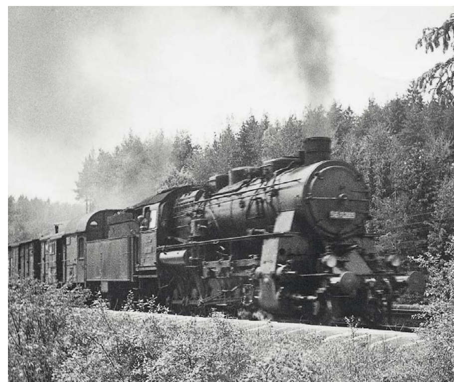
Auffällige BR 58: Die kleinen Höcker am Kessel oben vor dem Führerhaus verraten den eckigen Belpaire-Stehkessel – seine Form bot mehr Raum zur Dampfbildung.
