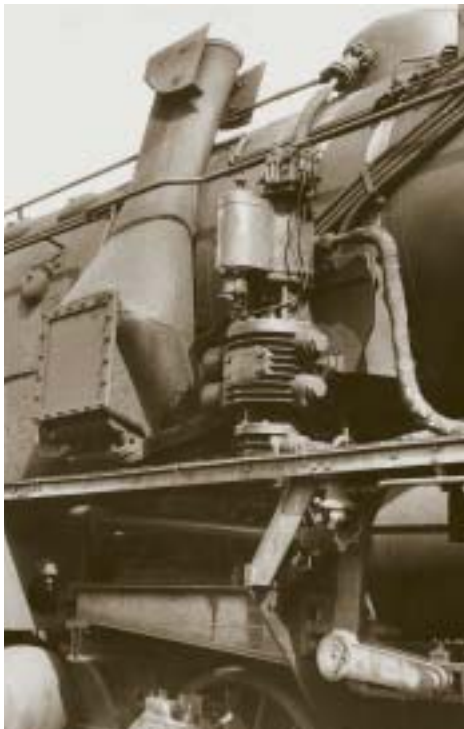
Charakteristisches Merkmal der Franco-Crosti-Maschinen waren die beiden elliptischen Hauptschornsteine. Zur besseren Sicht für den Lokführer und den Heizer schmiegen sie sich eng an den Kessel.
